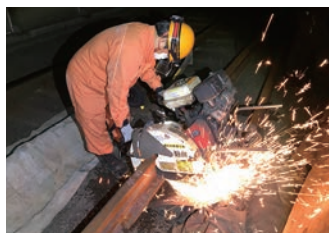
レール切断作業
