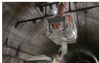
軌陸車を使用した架線設備点検
