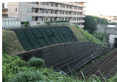
対策後の斜面（同区間）
