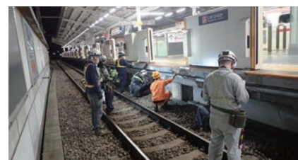
構造物（ホーム）検査
