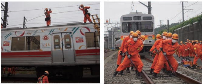
電気係員による電車線張り替え作業 保線係員による線路の歪み修正作業
